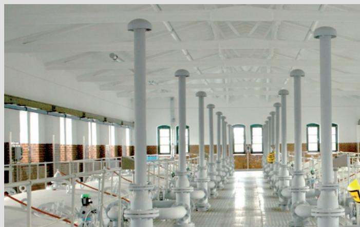
Des filtres Bollmann dans une station hydraulique, enduites avec KefaTherm
